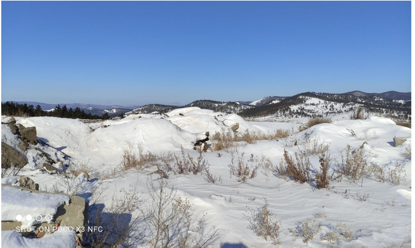
Рис. Б.10 – Свалка п. Стеклозавод, общий вид, зима 2021
