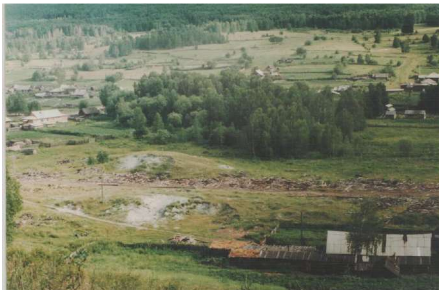
Рис. 5.10. Общий вид головной части хвостохранилища Майской ЗИФ. Светлые обнажения, места взятия хвостов для хозяйственных нужд [95]
