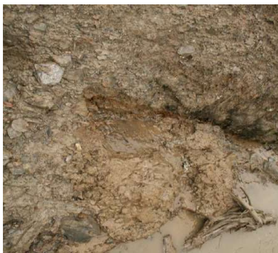
Рис 4.44. Область разгрузки техногенного фильтрата в р. Безымянный из подошвы южной ограждающей дамбы хвостохранилища Советской ЗИФ.
