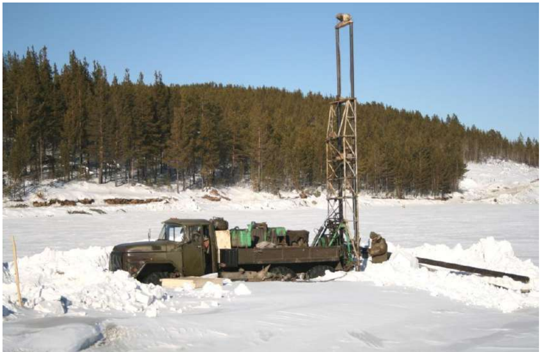
Рис.1.7. Бурение колонковой скважины со льда пруда отстойника отсека № 2 хвостохранилища Советской ЗИФ.
